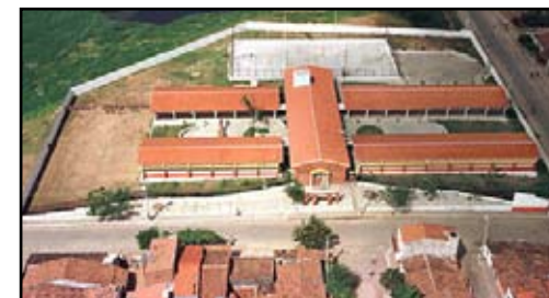
Reforma da quadra beneficiará comunidade escolar
